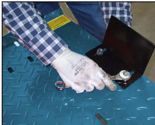
Figura 11 – Montaggio della piastra ferma ruota.
